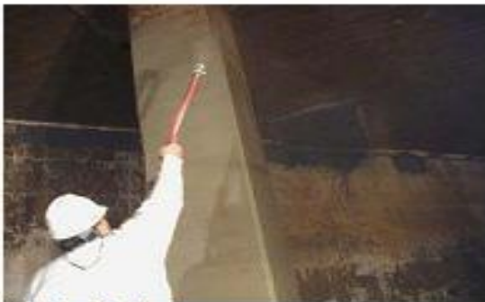
Thi công bằng bơm
