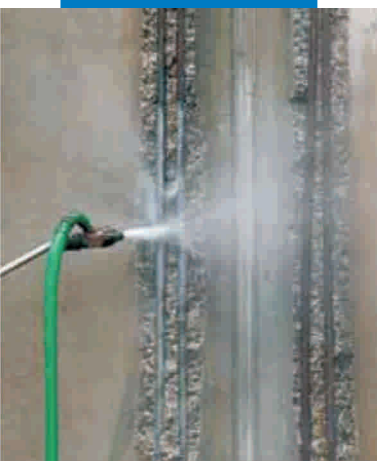
Vệ sinh cốt thép
