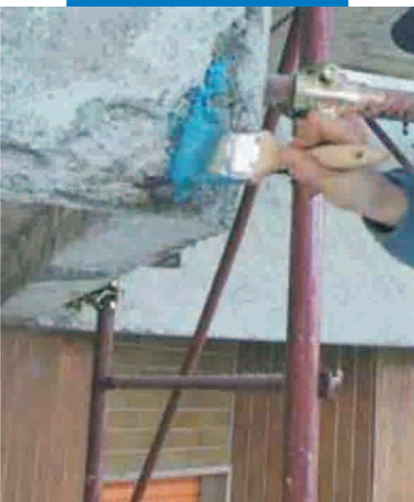
Thi công Mapefer 1K bằng chổi quét lên cốt thép cho ở bê tông ở ban công
