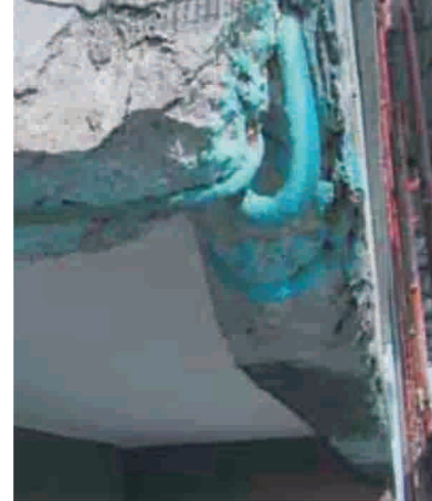
Cốt thép bê tông ở mặt trước của ban công được bảo vệ bằng Mapefer 1K
