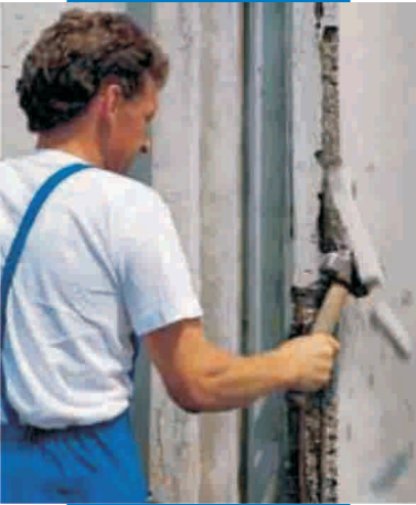
Loại bỏ phần bê tông bị hư hỏng
