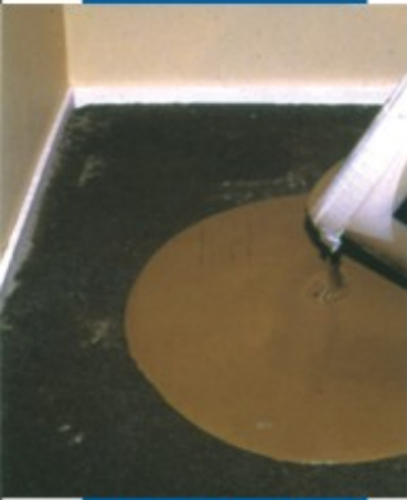
Thi công hỗn hợp dẻo Novoplan 21 lên trên bề mặt
