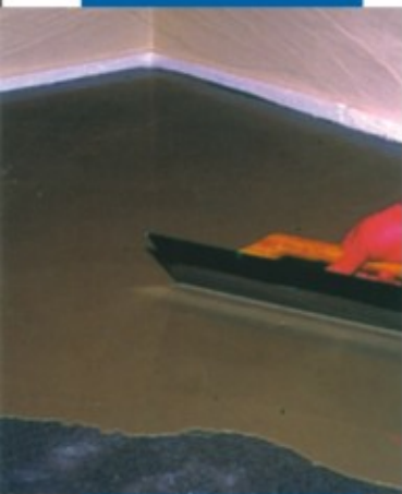
Thi công Novoplan 21 bằng bay kim loại lên trên vữa góc xi măng đã được sơn lót bằng Primer G
