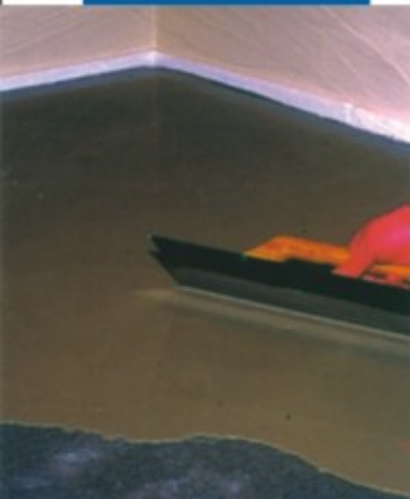
Thi công Novoplan 21 bằng bay kim loại lên trên vữa gốc xi măng đã được sơn lót bằng Primer G
