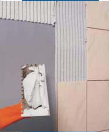
Ốp lát gạch trên bề mặt đứng
