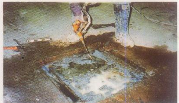
Xử lý rò rỉ nước cho móng hầm
