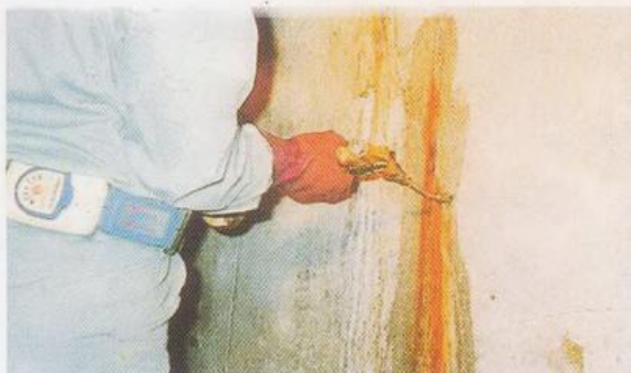
Xử lý rò rỉ nước cho tường vây
