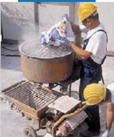
Chuẩn bị sản phẩm bằng phương pháp cơ học trước khi bơm
