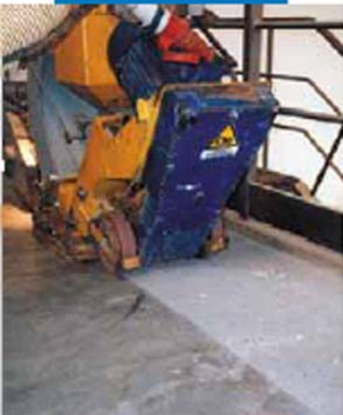
Chuẩn bị bề mặt thi công bằng máy mài
