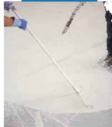
Thi công Ultratop bằng phương pháp cơ học
